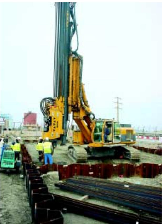
I materiali e le attrezzature previste per l'opera erano: una macchina universale per la perforazione e lo scavo (RG 18 t), un vibro-infissore (MR100V-02), palancole tipo ARBED PU22, acciaio S355GP di 14 m di lunghezza e un rivestimento Baltoflake de Jotun.
