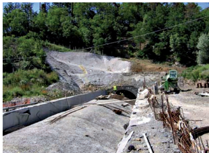
Fig. 4.9. - Esecuzione galleria artificiale zona Rio Pescigola.
