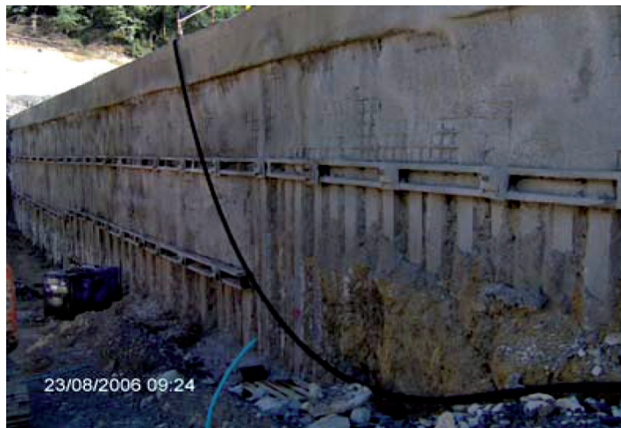
Fig. 4.7. – Scavo galleria Dorbola Zona Rio Pescigola. Fasi di ribasso paratia in micropali con tiranti passivi costituiti da bulloni autopercoranti.
