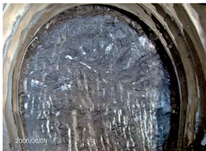
Fig. 4.11. - Scavo galleria Bibola alla pk1+004 (a 54m da progr. di imbocco). Fronte in argilliti omogenee. Sezione tipo applicata IV.
