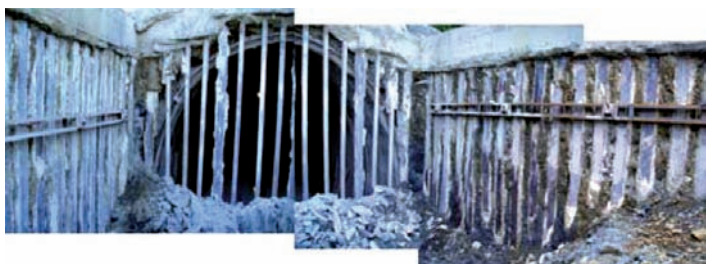
Fig. 4.8. - Galleria Dorbola. Abbattimento diaframma di uscita in corrispondenza galleria artificiale zona rio Pescigola.
