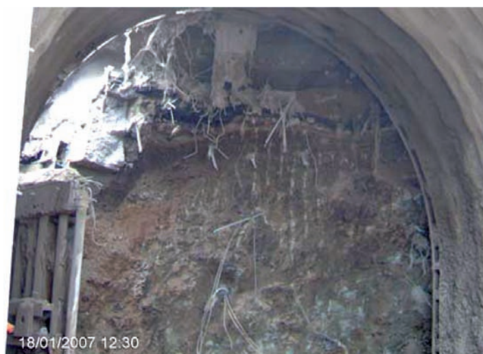
Fig. 4.17. - Fase di scavo al di sotto della SS Del Cerreto (1° campo di avanzamento) . Si nota ancora parzialmente la paratia di imbocco gradatamente demolita.
