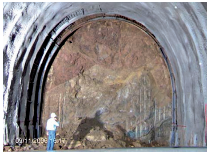
Fig. 4.13. – Scavo galleria Dorbola da Aulla (progr. 1+545). Fronte di scavo in Ofioliti. Sezione tipo applicata III.
