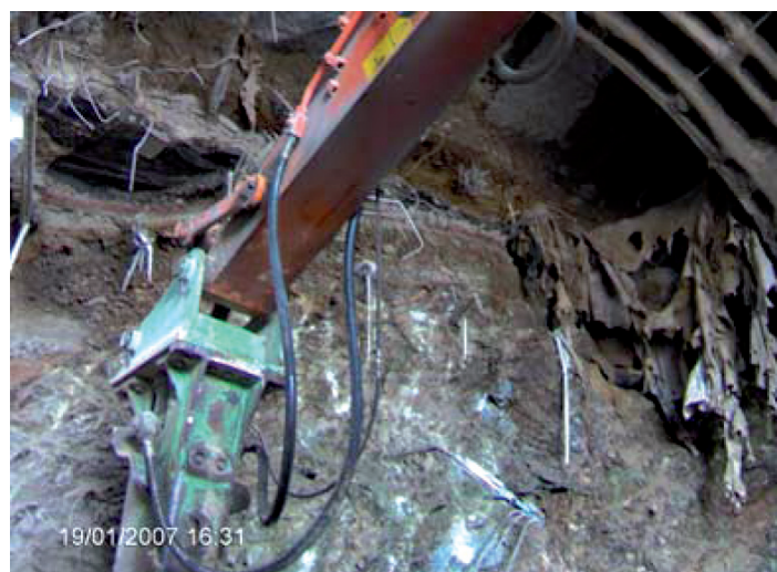
Fig. 4.18. - Fase di scavo al di sotto SS Del Cerreto (si nota il pacchetto stradale esistente ed i brandelli di TNT a delimitare il materiale riportato in calotta) .
