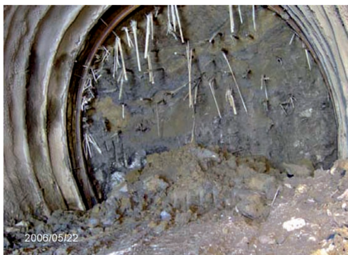
Fig. 4.10. - Scavo galleria Bibola alla pk1+029 (a 29m da progressiva di imbocco lato Aulla). Fronte misto in argilliti disarticolate e depositi eluvio-colluviali in sommità calotta. Sezione tipo applicata V/C2.
