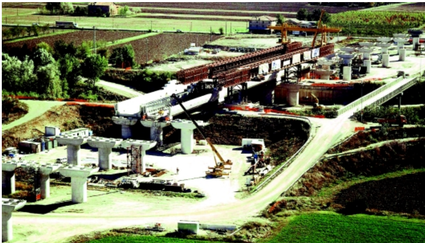
Scavalco iperstatico fiume Secchia
