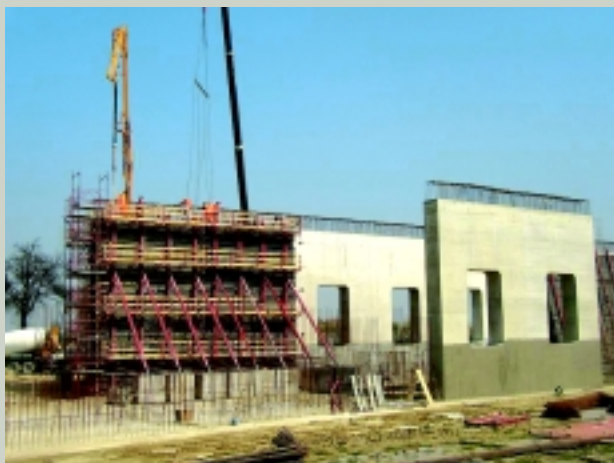
Galleria artificiale GA 18
