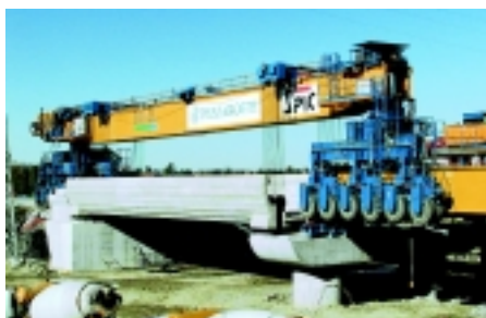
Varo 1° trave del "sistema viadotti Modena"
