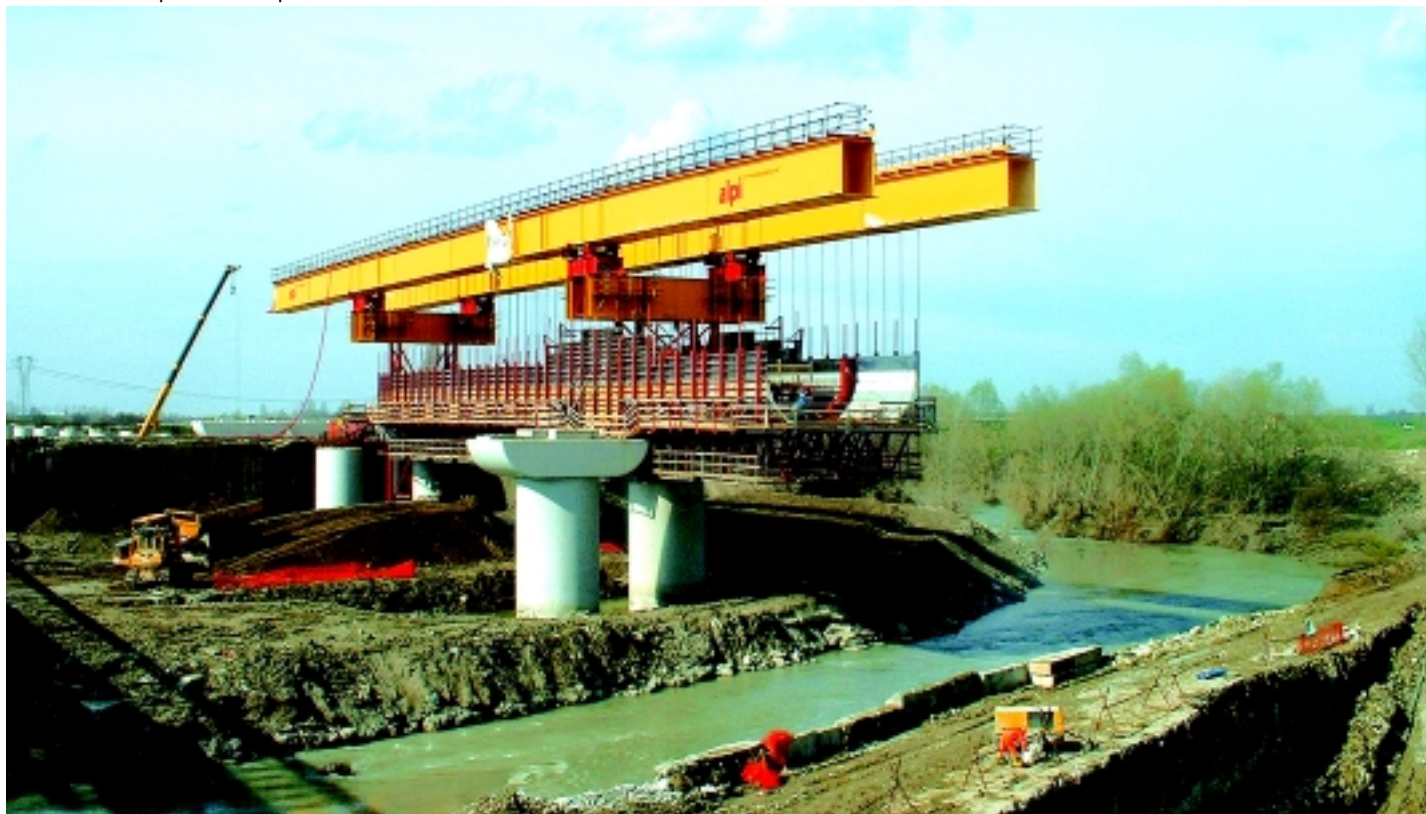
Casserratura campata iniziale iperstatica Panaro
