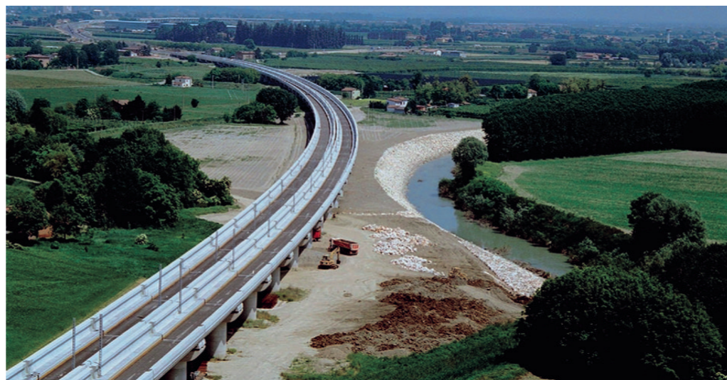
Grandi opere Il presidente Paolo Pizzarotti e sotto due delle tante opere realizzate dall'impresa parmigiana: la stazione di interconnessione tra le reti di trasporto interurbano TGV-RER dell'aeroporto Charles De Gaulle a Parigi e un viadotto nella gola del fiume Secchia (Modena) sulla linea dell'Alta Velocità Milano-Bologna.
